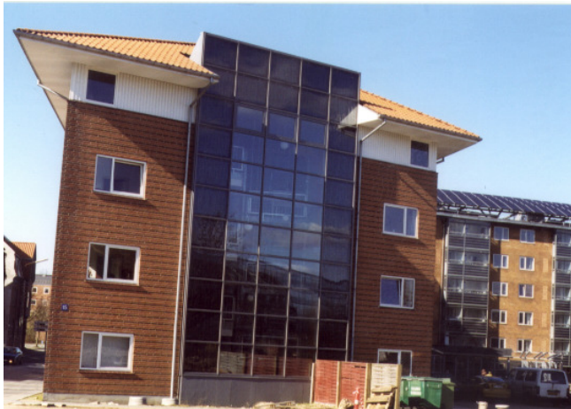
Pav. 7.2 Kolektoriai integruoti į pastato fasadą Danijoje (Šaltinis: Batec/ESTIF).
