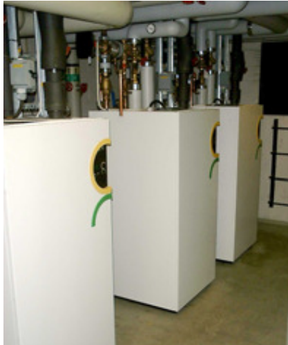
Pav 7.6 Šilumos siurbliai šilumą imantys iš išmetamo ventiliacijos oro (žiemos metu), taip pat gali būti naudojami kaip vėsinimo įrenginiai (vasaros metu). (Šaltinis: IVT šilumos siurbliai dideliems pastatams).
