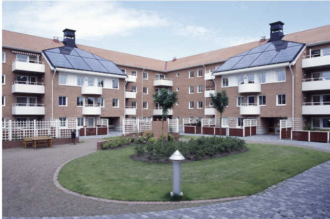
Pav. 7.1 Saulės kolektoriai gyvenamajame pastate Švedijoje (Šaltinis: Aquasol).
